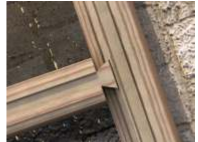
Pół czenie ciany zewn trznej ze ciany wewn trzn na półzamek teowy w jaskółczy ogon.
